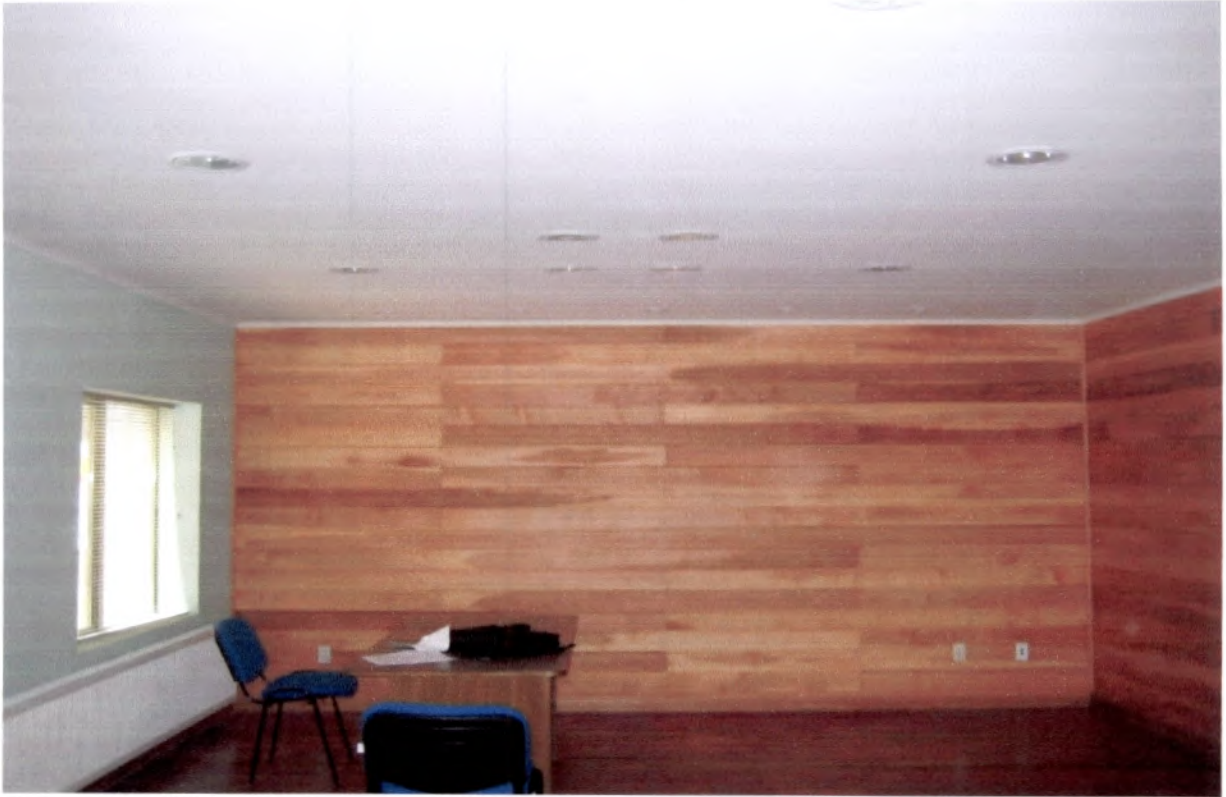
Fotografía N°1: Falta la instalación de Natura Hunter Douglas en cielo y muro.
