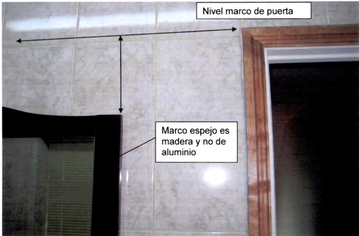
Fotografía N°3: Espejo no cumple con la altura a vano de puerta, ni marco es de aluminio anodizado.
