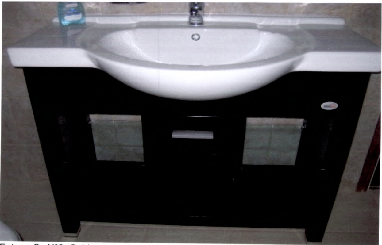
Fotografía N°2: Cubierta de vanitorio de enlozado y no de mármol.
